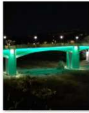
Pasarela de Vianants, Picanya Valencia.jpg
